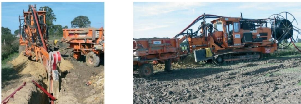
Figure 11 : Trancheuse à disque en action - Ora Environnement
