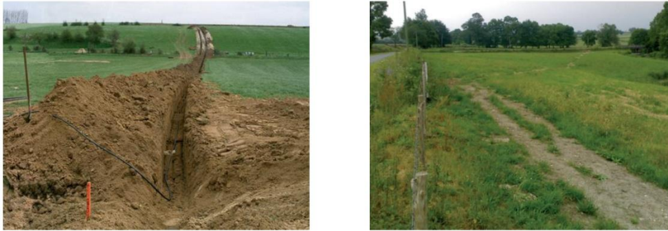
Figure 10 : Exemple de tranchée ouverte et de tranchée fermée depuis 2 mois - Ora Environnement
